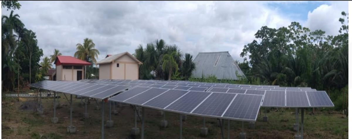
**Descripción fotografía:** Instalación de paneles solares en la CCNN San Fernando, los mismos que dotarán de energía para el óptimo funcionamiento de las plantas de hielo, lo que permitirá una comercialización de pescado amazónico fresco. Es preciso remarcar que cada planta producirá diariamente 500kg de hielo.
